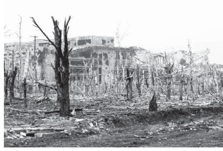
Здание аэропорта до и после обстрелов
