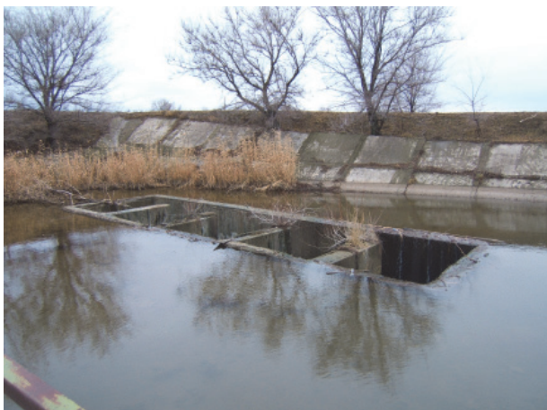
Рис. 2. Поступление волжской воды в р. М.Узень (самотечная) часть протяженностью 41,5 км проходит по естественному руслу р. Сазанлей (11,5 км), затем по руслу канала до Сулакского водохранилища (30 км). Левобережная начинается от Сулакского водохранилища и представляет собой левобережный канал в земляном русле протяженностью 36 км, оборудованный пятью перекачивающими стационарными насосными станциями. Головная насосная станция осуществляет водозабор из Сулакского водохранилища, а четыре промежуточные станции подают воду через водораздел высотой 92 м в бассейн рек Б. Узень и М. Узень [1].
